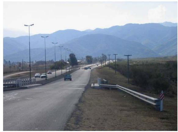
*Falta de continuidad geométrica y estructural entre la barrera de aproximación al puente y la barrera del puente; además embolsamiento*
