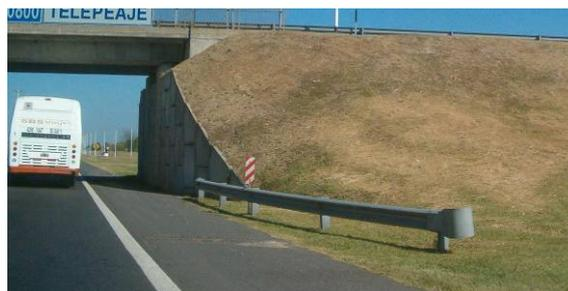
La instancia más común ocurre en autopistas cuando se usa un sistema de barrera para proteger las pilas, pero de insuficiente longitud para impedir que un vehículo errante viaje sobre los taludes del estribo y sea redirigido hacia la parte trasera de la barrera o frente o lado de las pilas, de seguir por dentro de una característica no traspasable, o de simplemente volcar en un empinado talud de estribo. Los taludes de estribo deberían ser traspasables o estar adecuadamente protegidos.
