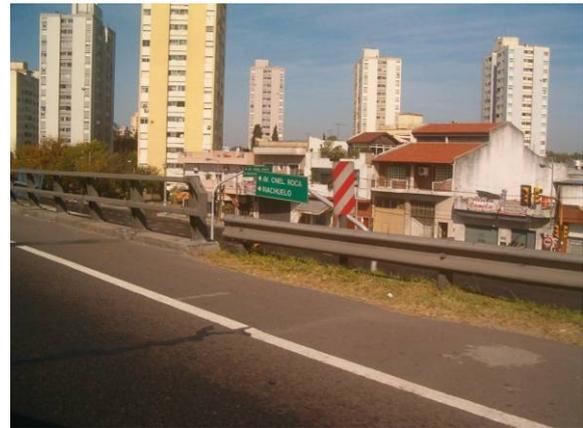
*Falta de continuidad geométrica y estructural entre la barrera de aproximación al puente y la barrera del puente*
