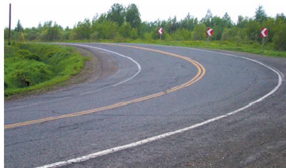
Para introducir gradualmente el peralte es necesaria una zona de transición entre recta y curva horizontal. En parte de esta zona, el perfil del camino se vuelve casi plano, lo cual conduce a la acumulación de agua y contribuye al deslizamiento.
