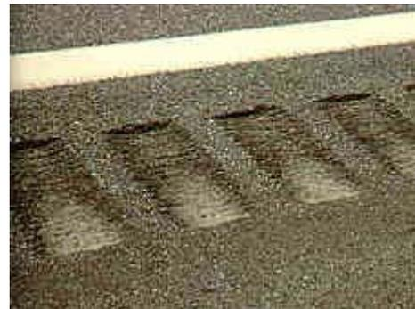
Ventajas: pueden ser instaladas sobre superficies nuevas o existentes de asfalto u hormigón; no afectan negativamente a la estructura del camino (espesor mínimo de pavimento debe ser de 6 cm); producen elevados niveles de ruido y de vibración, lo que es especialmente importante para grandes vehículos comerciales. Desventaja: costo.
