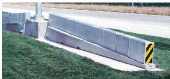
materiales es prefabricado y moldeado en módulos reforzados con malla de alambre y cubiertos con material adecuado para prevenir la penetración de agua, no se construye in situ. La mezcla para los terminales de esta barrera se diseña y se controla de tal manera que se puede asegurar la desaceleración controlada. Son recomendados para estaciones de peaje y en particular para las vías de telepeaje.
