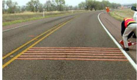
La preferencia mayoritaria de uso son las franjas sonoras fresadas y en segundo lugar las rodilladas; las fresadas producen un nivel de ruido y estímulo vibratorio más alto que las rodilladas. El esquema de ranuras puede instalarse en forma intermitente o continua. El esquema, profundidad, ancho, forma y espaciamiento del ranurado puede ser variable.
