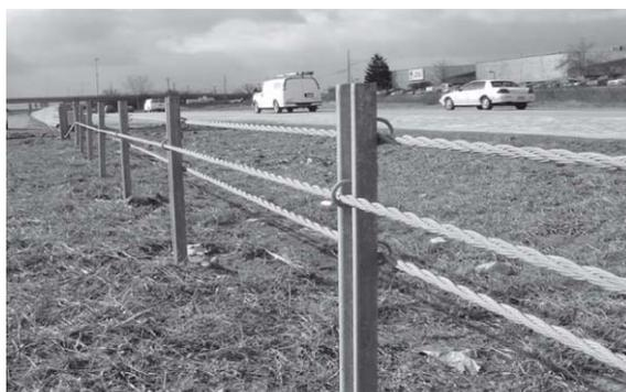
Figura 7.61 Sistema de cable de tres hilos en mediana
