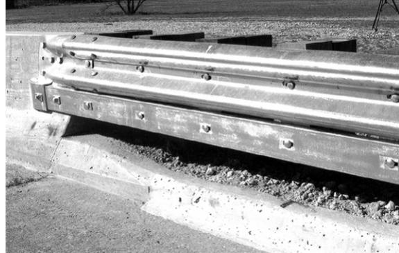
*Transición de una barrera de aproximación tipo viga W a una barrera de hormigón tipo New Jersey utilizando un complemento de viga de fricción.*
