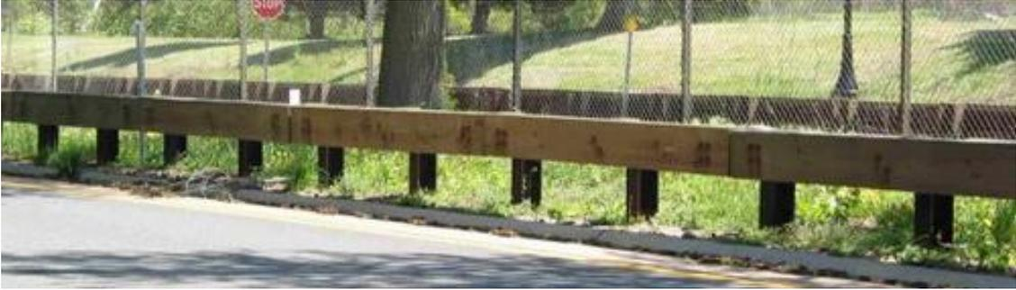
Figura 7.41 Sistema de viga rectangular con respaldo de placa metálica
