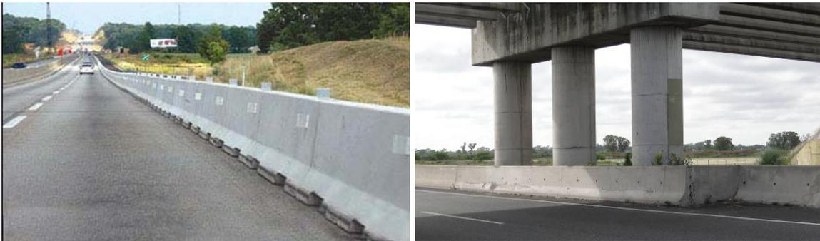
Preferiblemente, las barreras rígidas de forma segura de hormigón (FSH) deberían estar contiguas a una superficie pavimentada, de modo que las ruedas no puedan enterrarse en el suelo y causar el vuelco del vehículo.
