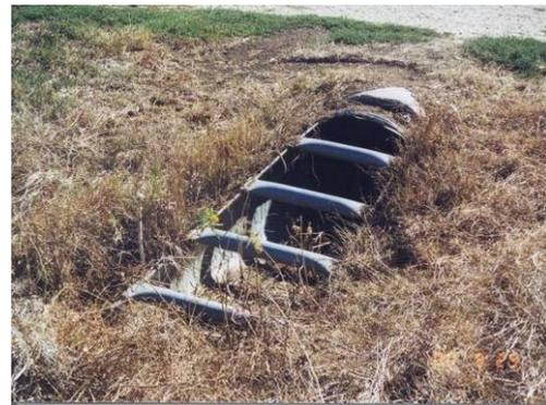
Por condiciones de ZD u otro motivo, puede ser necesario solamente colocar rejas en la desembocadura de una alcantarilla, en estos casos se deberá también colocar rejas en la embocadura para evitar el taponamiento en el interior de la alcantarilla.
