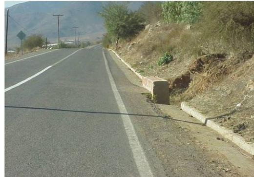
Aunque estos tipos de diseños de extremos sean hidráulicamente eficientes y minimicen los problemas de erosión, pueden representar un peligro para el vehículo que circula fuera de la calzada. Los extremos generan:
