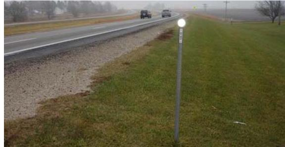
Usualmente los postes guía tienen un dispositivo reflectivo adherido, a menudo referido como delineador montado en poste (DMP), los cuales ayudan a la delineación de alto rango durante la noche.
