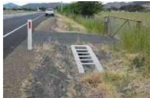
Proteger una alcantarilla con una barrera es la última opción cuando no se puede extender la alcantarilla mas allá de la ZD y no es factible proyectarlas traspasables con rejas. La barrera se diseña según Subsección 7.6.2. No se deben usar barreras de hormigón para proteger alcantarillas en la ZD.
