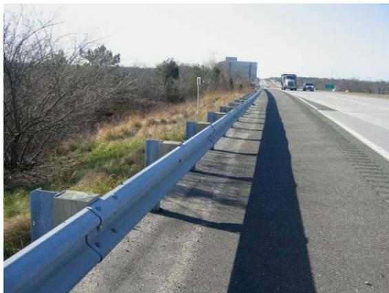
Estas defensas actúan separando la energía cinética del vehículo que la impacta en componentes en las tres direcciones:
