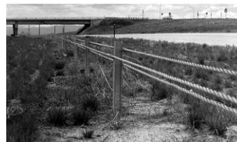
Las barreras longitudinales se utilizan para proteger a los conductores de los peligros naturales o artificiales al costado del camino. Ocasionalmente se usan para separar al tránsito de peatones, ciclistas. El propósito primario de todas las barreras es impedir que un vehículo que deja el coronamiento golpee un objeto fijo o transite por características del terreno más peligrosas que la barrera misma.
