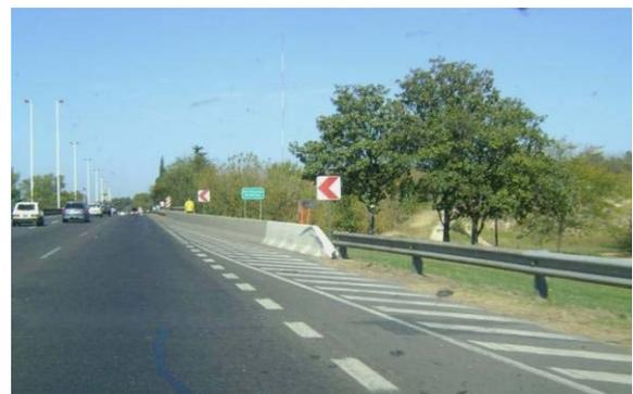
*A la izquierda, falta de continuidad geométrica y estructural entre la barrera de aproximación al estribo y el estribo; a la derecha entre barreras de diferente rigidez*
