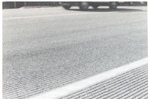
La resistencia al deslizamiento se deteriora con el tiempo; se recomienda su monitoreo para mantenerla en niveles aceptables, especialmente en condiciones húmedas y resbaladizas. La necesidad de un tratamiento puede evaluarse mediante máquinas capaces de medir la resistencia al deslizamiento del pavimento, como los dispositivos: *SCRIM* (*Sideways Force Coefficient Routine Investigation Machine*), *British Pendulum Tester*, *GripTester*, *Trailer ASTM*.
