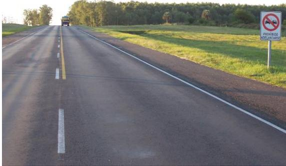
Las curvas verticales convexas con deficiente DVD que oculten otras características existentes (curvas cerradas, estructuras angostas, accesos a propiedad, intersecciones, etc.), incrementan el riesgo y la gravedad de los accidentes.
