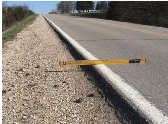
Aun si pudieran determinar las profundidades, los conductores no suelen reconocer el peligro real que una caída de 5, 8 ó 10 centímetros pueda tener. El *Transportation Research Board* las considera entre las causantes de los más peligrosos accidentes relacionados con el pavimento, y los choques relacionados con las CBP suelen resultar en significativos reclamos por daños y perjuicios.
