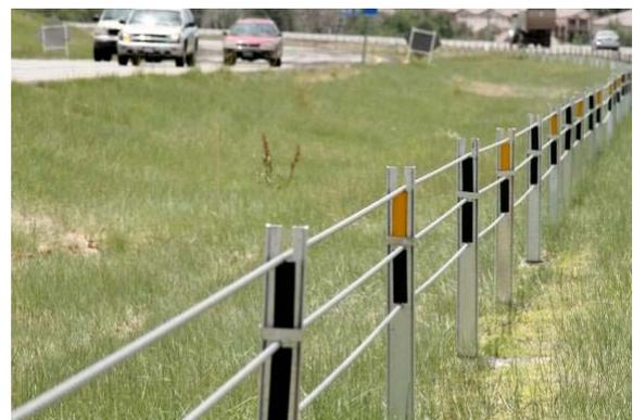
La energía producida por el impacto es disipada a través de la tensión que absorben los cables de acero. Como son barreras patentadas será responsabilidad del fabricante de este tipo de barreras determinar, en función de las pautas de diseño, los materiales más adecuados para este sistema de contención.
