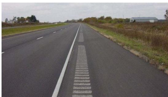
Sobre la línea de borde de la calzada, FSLBo: una variante de la FSBa, que coloca las líneas de demarcación del pavimento sobre la franja sonora; se utilizan comúnmente en caminos con banquetas estrechas.
