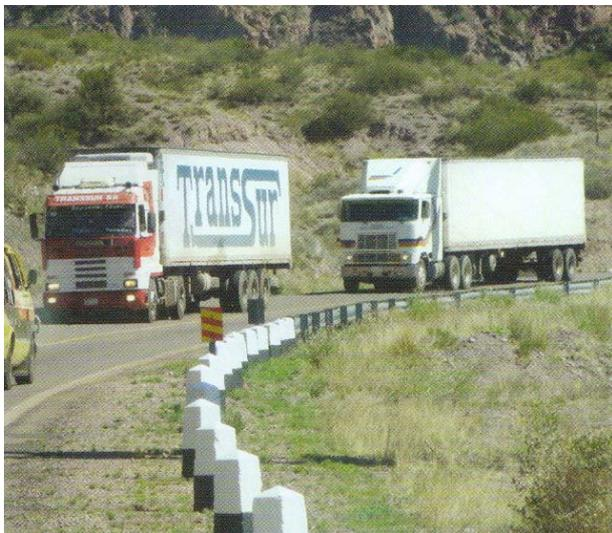
*Pretilos peligrosos en ZD, discontinuidad geométrica y estructural con barrera metálica. Señal tipo 'ironía siniestra' según Palazzo.*
