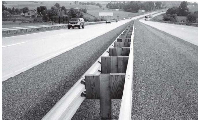
Figura 7.38 Sistema viga W con bloque separador de madera en mediana
