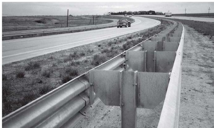
Figura 7.39 Sistema viga triple onda para mediana con bloque separador modificado
