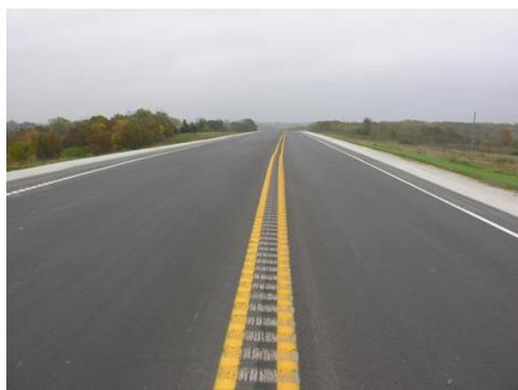
El hecho de aplicar las FS sobre las líneas de pavimento –FSLE y FSLBo- agrega a los efectos audibles y táctiles propios de las franjas sonoras, el efecto visual: la pintura retrorreflectiva incrementa la visibilidad del borde de carril (lateral y del centro) durante la noche y en tiempo inclemente (p. ej. lluvia).
